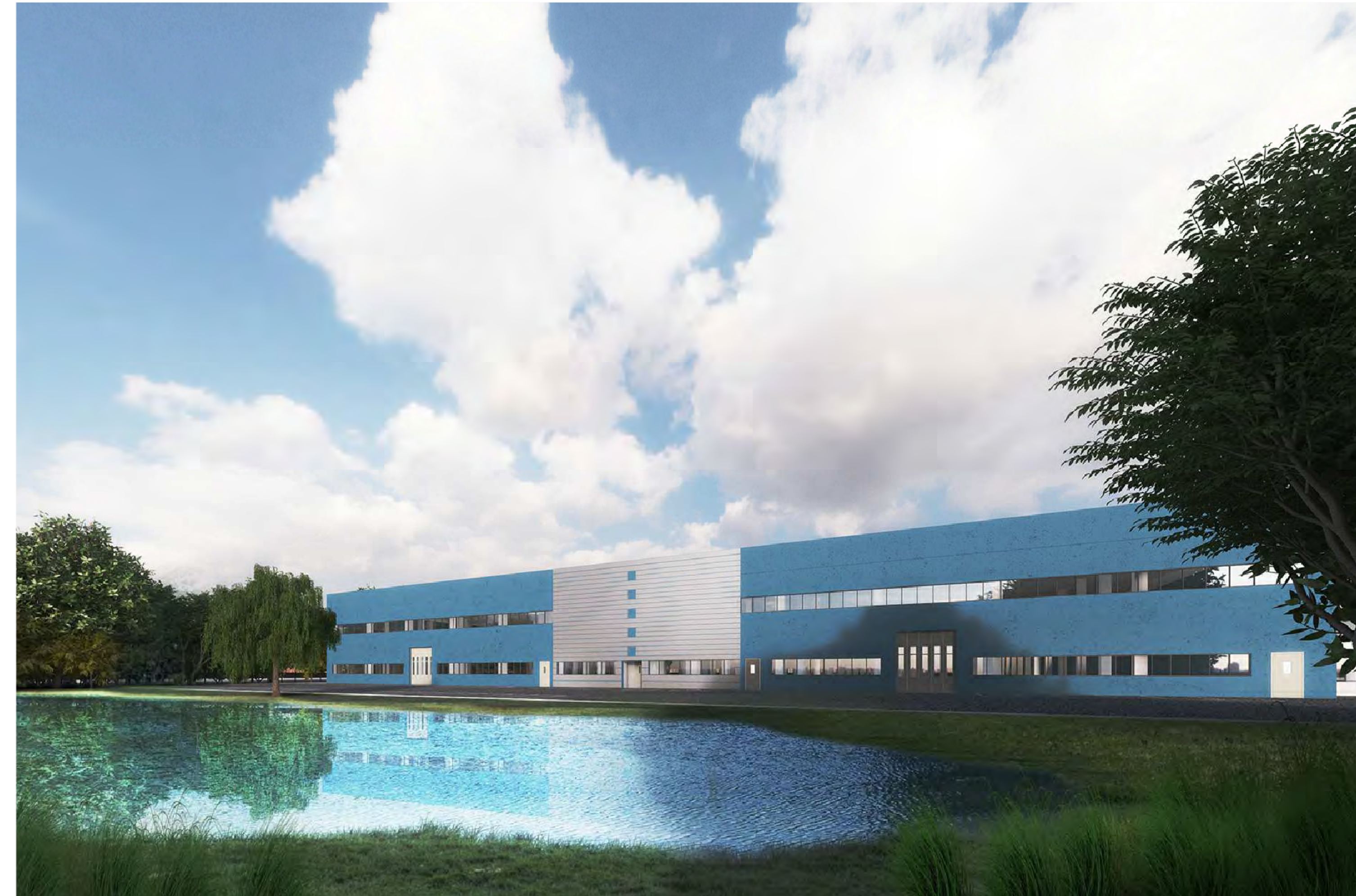
VISTA 01 / INGRESSO PRINCIPALE lato SUD-OVEST
