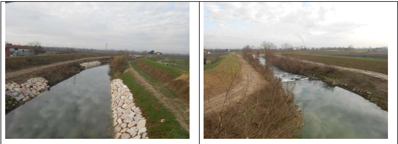
Fig. 4.44 a/b: Corridoio principale (Sito IT3240029 “Ambito fluviale del Livenza e corso inferiore del Monticano”)
