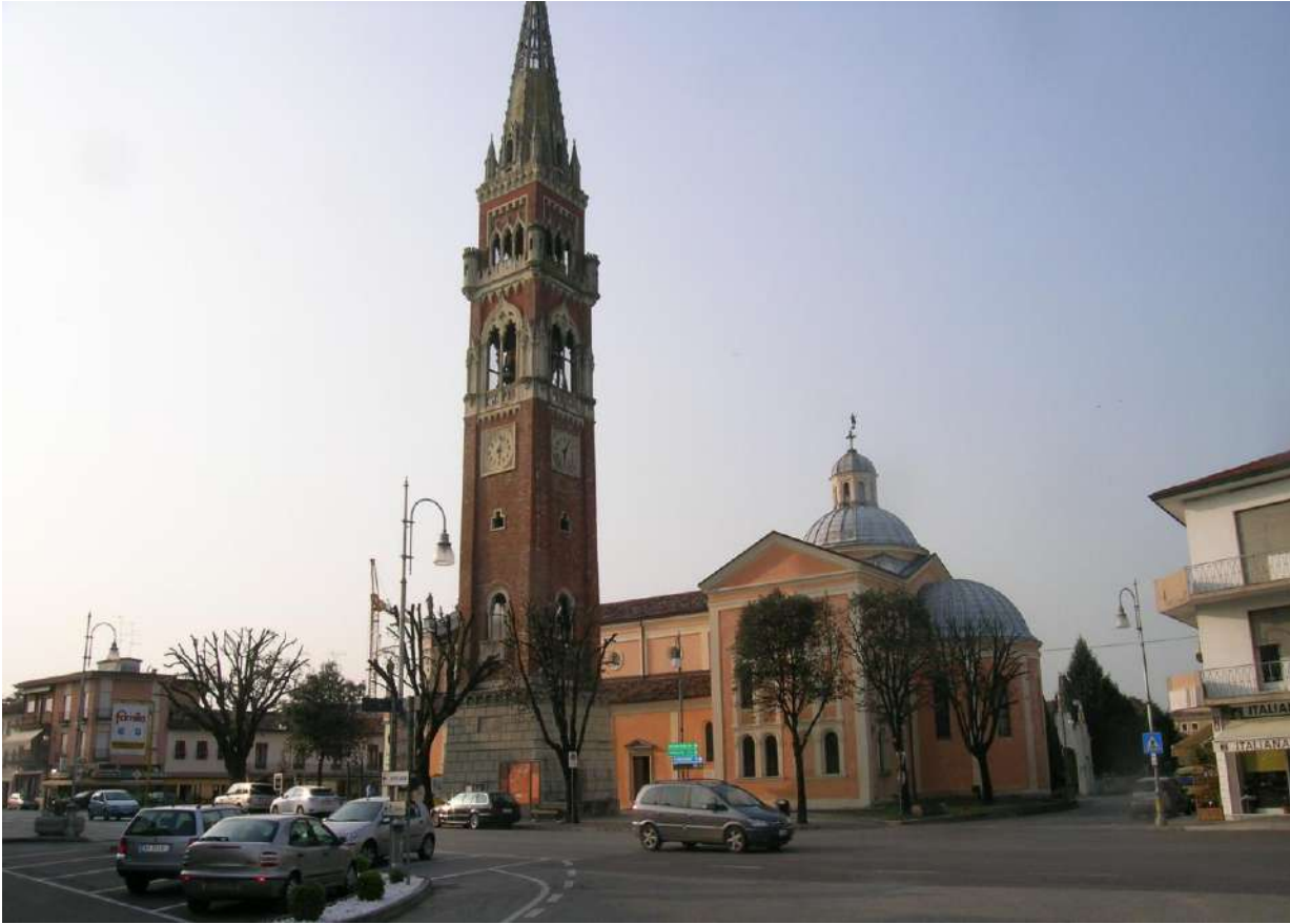
Fig. 4.59 Chiesa Parrocchiale di Vazzola con il campanile ricostruito dopo la I Guerra Mondiale
