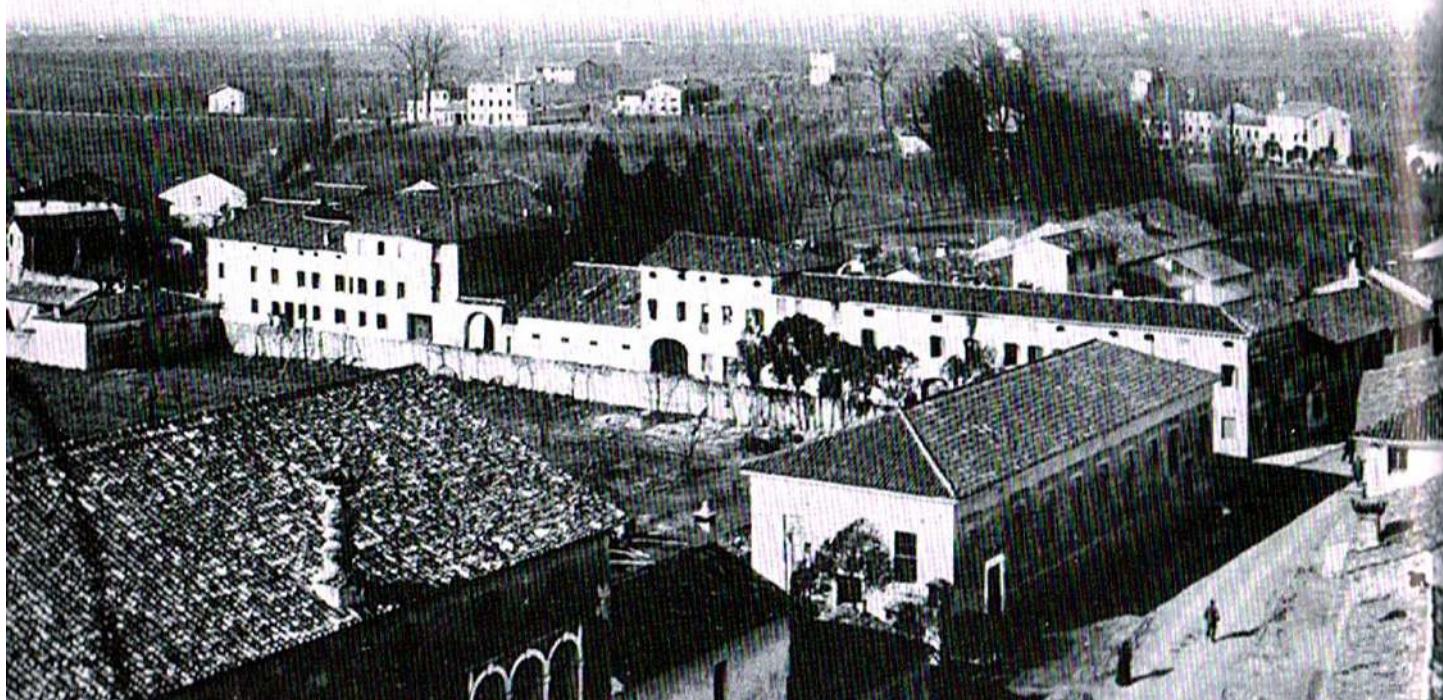
Fig. 4.85 Vazzola – Il settore ovest del Centro storico attuale - Foto militare austriaca dal campanile 1918.
