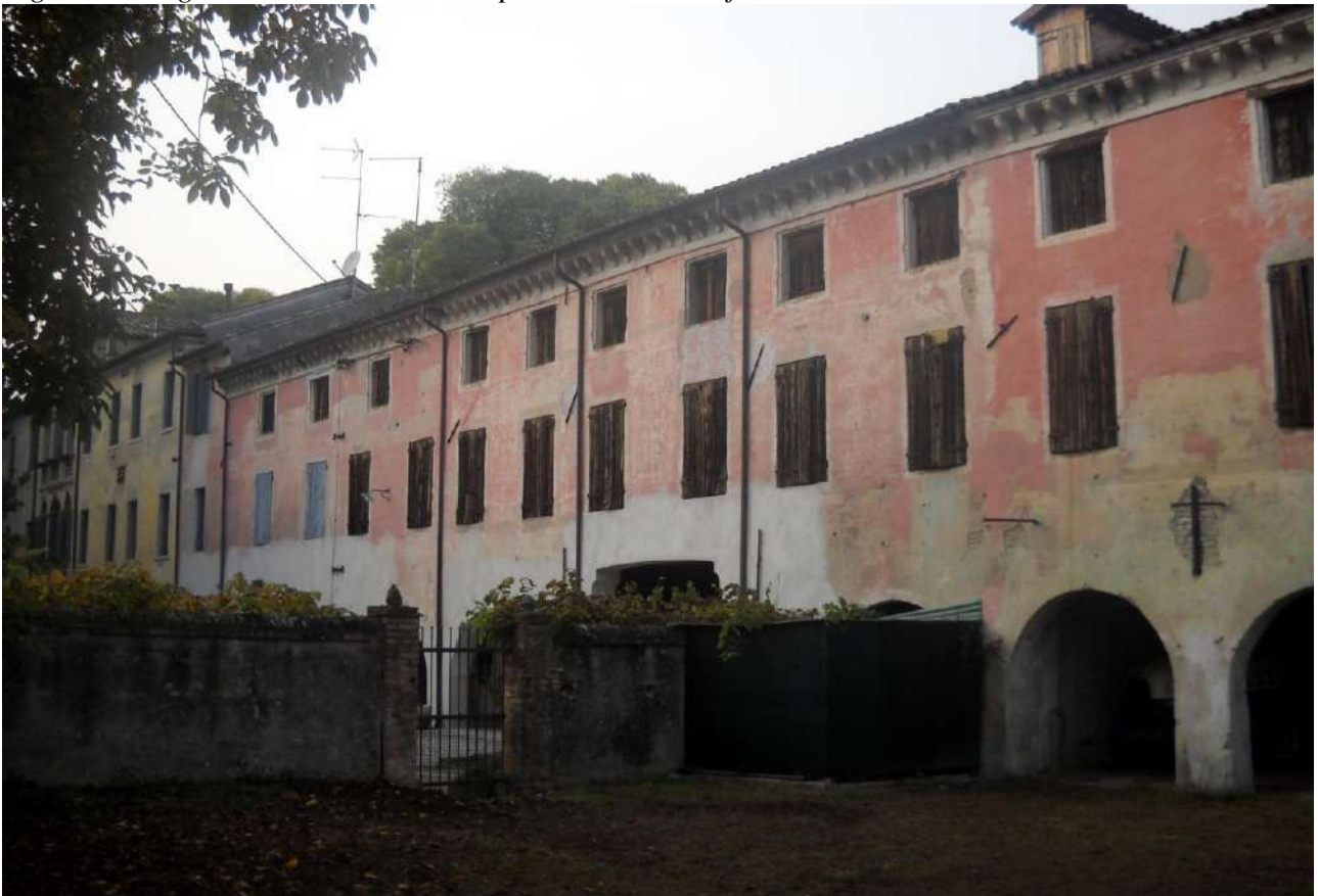
Fig. 4.96 Borgo Malanotte –Spazi interni cortilivi e seconda cortina edificata
