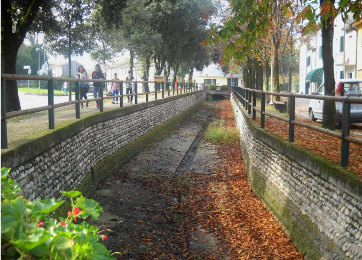
Fig. 4104 Il corso urbano del Favaro a Vazzola in seguito alla ricomposizione delle rive.
