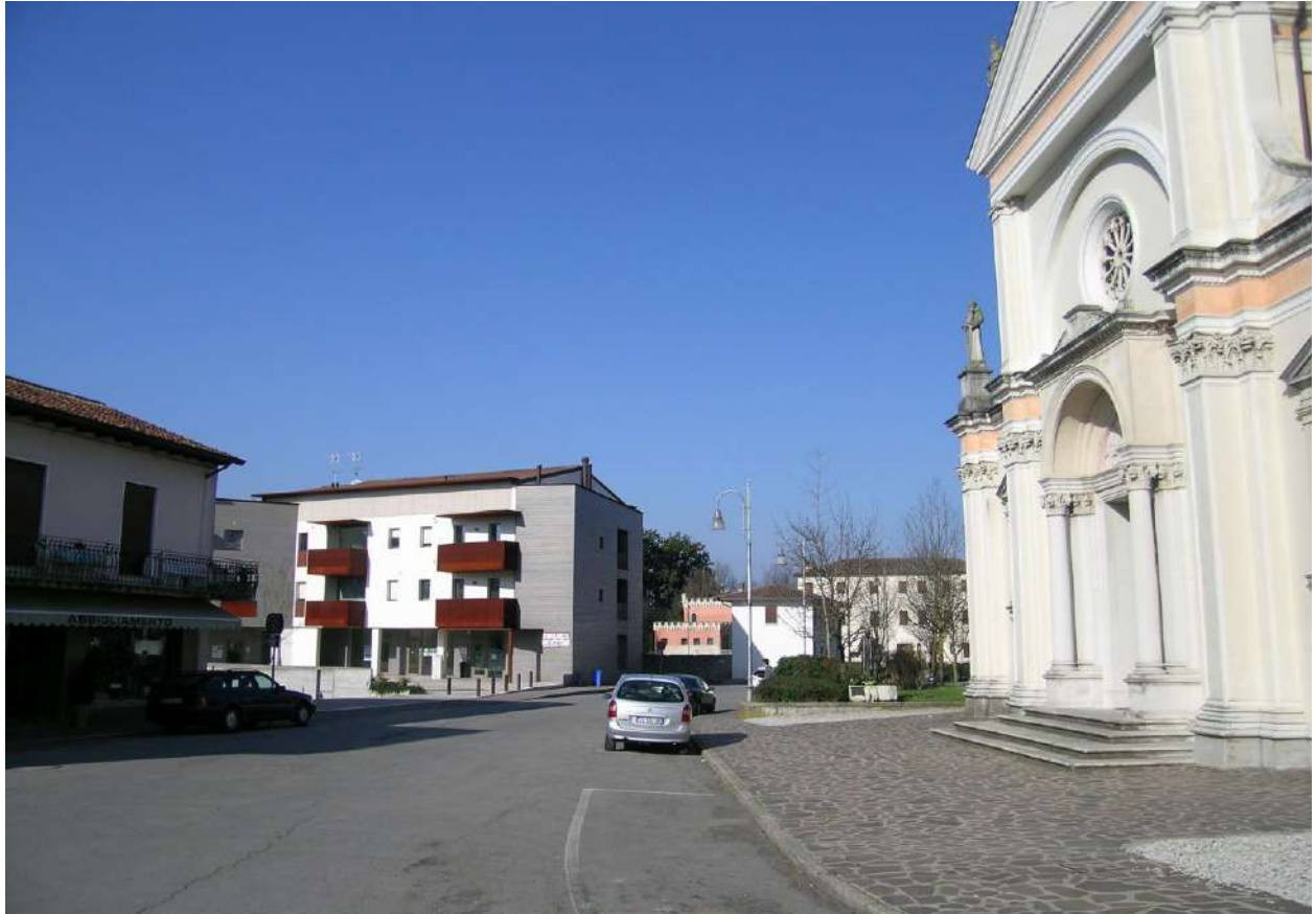
Fig.4.64 - Vazzola spazi centrali tra Chiesa, cortina ovest e Canonica da ricomporre in un'unica sistemazione urbanistica coerente.
