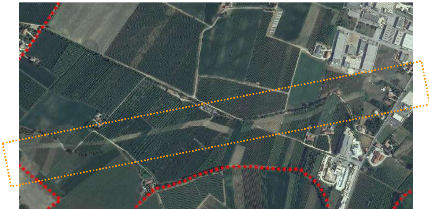
Fig. 3.25 – La traccia delle gasdotto in attraversamento dei vigneti di eccellenza a sud di Tezze
