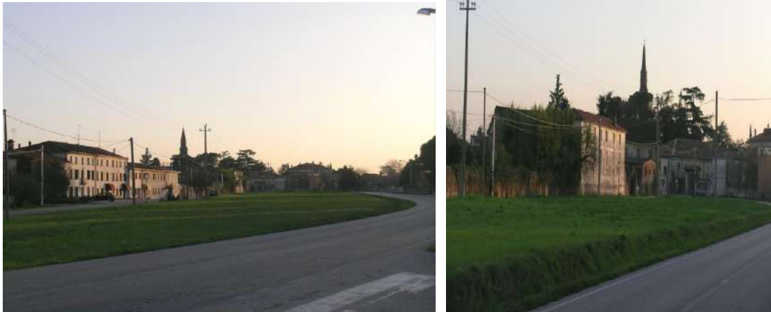
Fig. 4.170- Borgo Malta da nord
