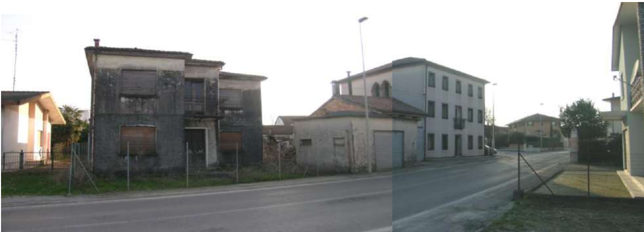
Fig.4.181 Nelle Aree di degrado si affiancano senza ordine edifici recuperati ed altri in abbandono.
