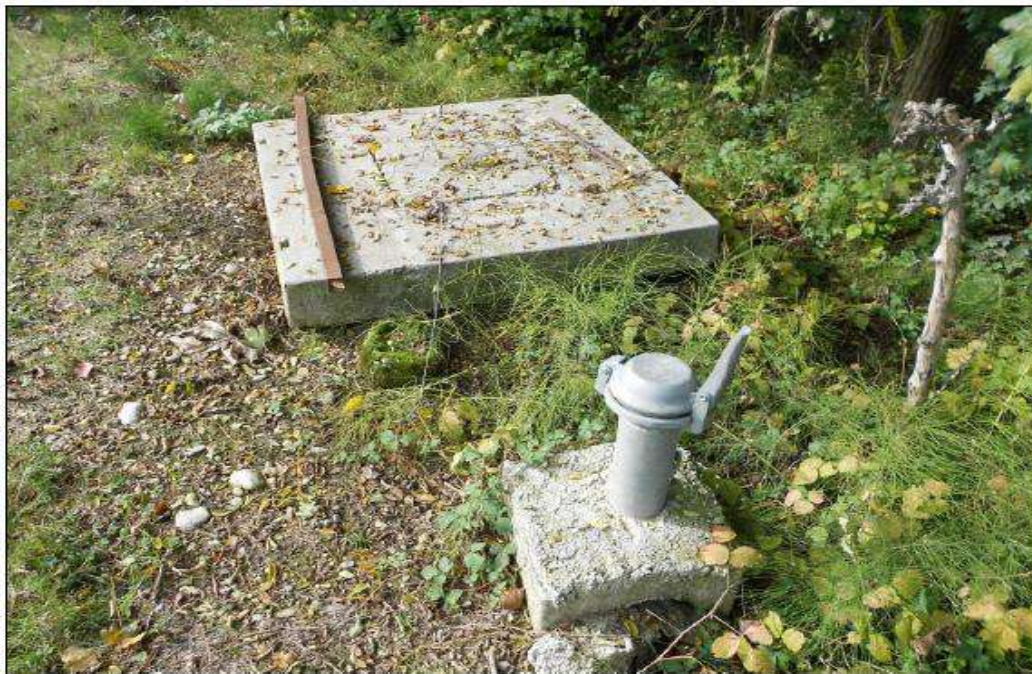
Fig. 4.75- Opera di captazione della risorgiva in località Le Chiezze presso il Molino Saccon
