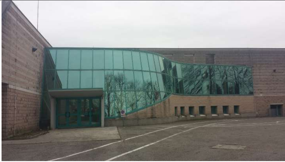
Palazzetto dello sport di Vazzola
