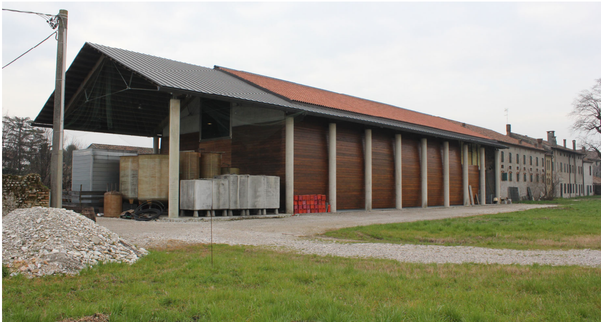
Figura 4. Vista nord est del volume realizzato nei primi anni 2000.
