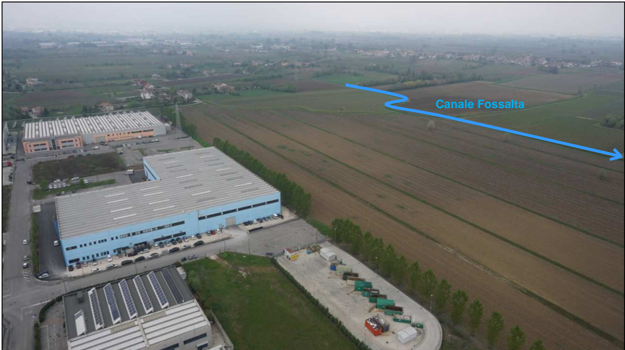
Figura 3.3: Fabbricato esistente con evidenziazione dell'alveo e direzione di flusso del canale Fossalta (Foto con drone - maggio 2017).
