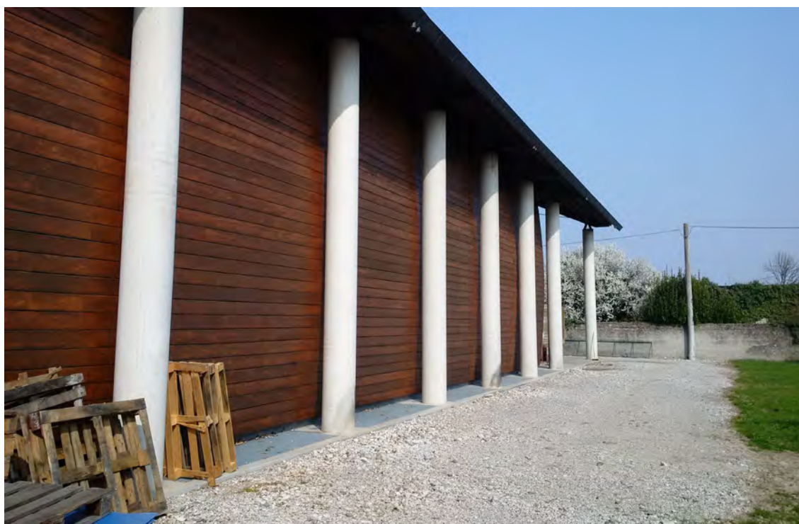
Vista sud della cantina esistente. Attuali pavimentazioni ora semipermeabili
