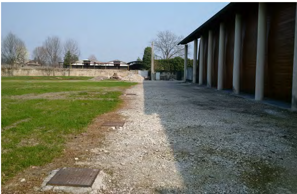
Vista nord della cantina esistente. Attuali pavimentazioni ora semipermeabili
