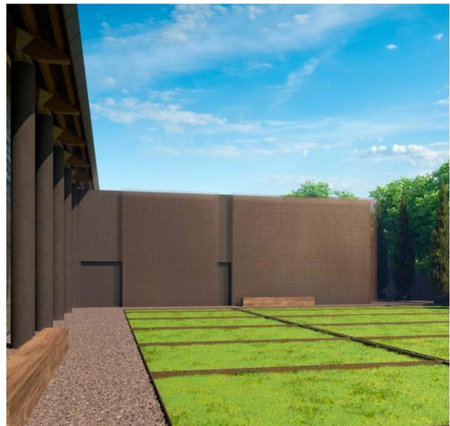
*Il rivestimento in rete si interrompe in corrispondenza delle aperture*
