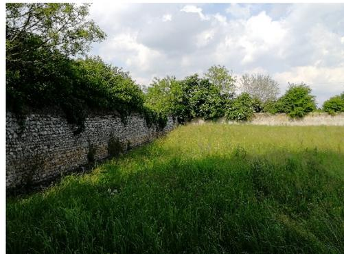
*Il muro di cinta del lato nord, con tessitura in sasso a vista*
