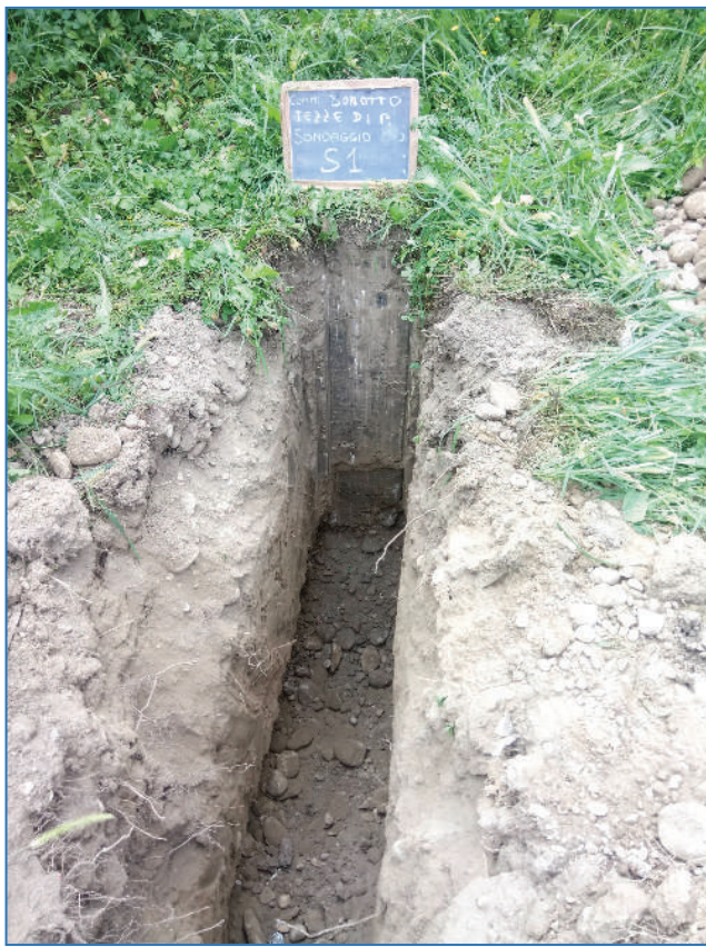
Fotografia 1 - Trincea geognostica S1
