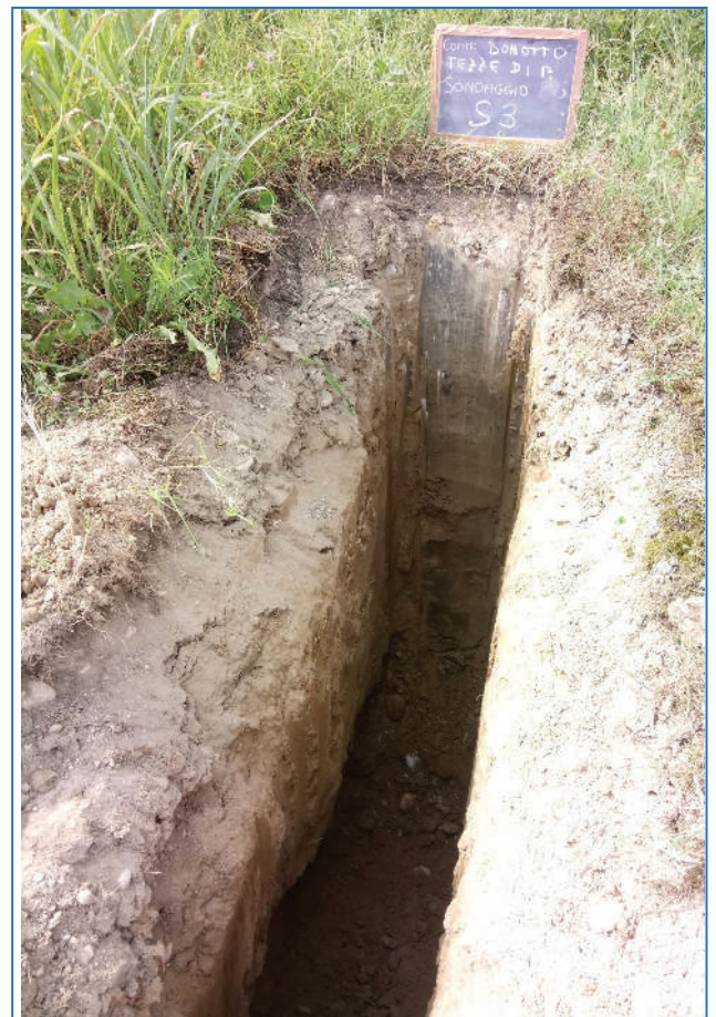
Fotografia 3 - Trincea geognostica S3
