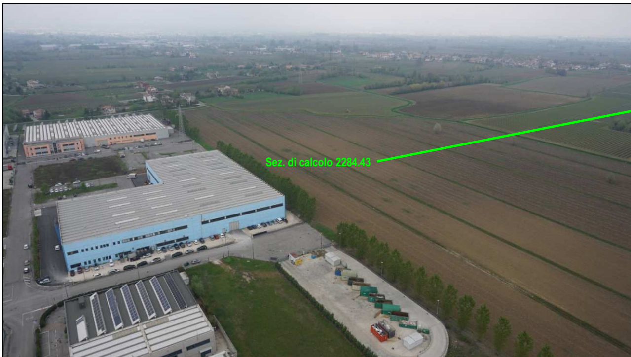
Figura 2.4: Fabbricato esistente con evidenziazione della sezione implementata nel modello idraulico (Foto con drone - maggio 2017).
