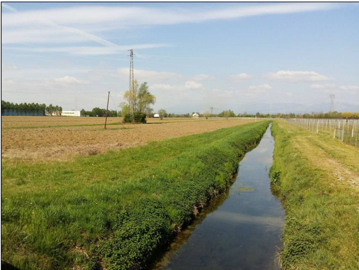
Figura 2.7: Canale Fossalta in prossimità del ponte di Via Cavour con vista dell'edificio esistente a sinistra.
