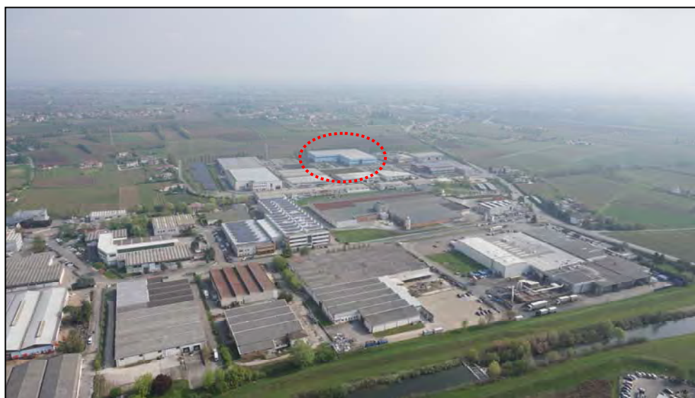
Sede centrale della ERAL S.r.l. in via Europa 14 a Vazzola posta a ridosso della parte centrale dell'estremo margine Nord della zona industriale di espansione di Vazzola (foto propria – ripresa da drone, aprile 2017).
