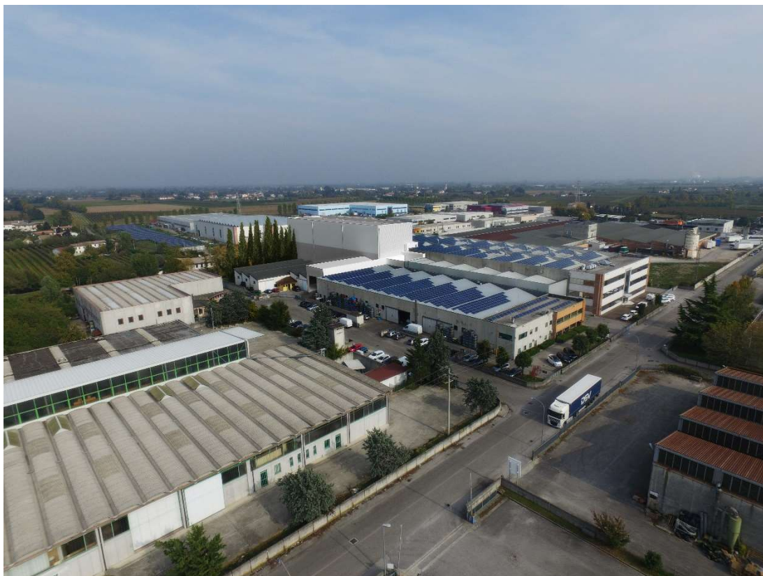
Figura 2.4: Fabbricati esistenti con inserita la sagoma del fabbricato in ampliamento (Foto con drone - ottobre 2017).
