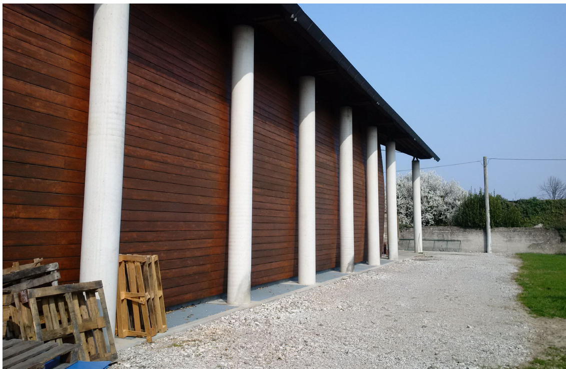
Figura 2: vista sud della cantina esistente. Attuali pavimentazioni ora semipermeabili
