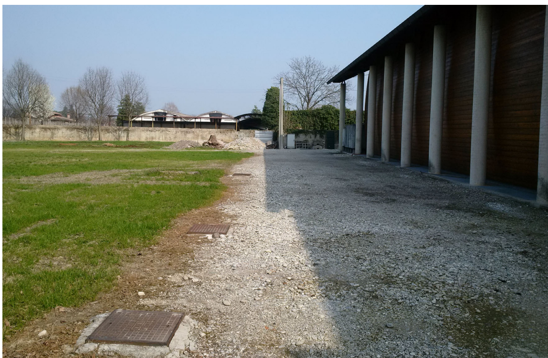
Figura 3: vista nord della cantina esistente. Attuali pavimentazioni ora semipermeabili
