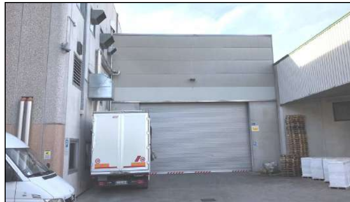
Figura 7 - Serranda di chiusura della facciata nord del tunnel coperto
