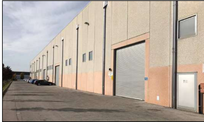
Figura 6 - Serrande lungo il fronte est dello stabilimento
