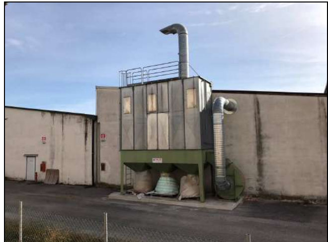
Figura 11 - Impianto di aspirazione ad est di Gi. Di. Meccanica S.p.A. (Sorgente S2)
