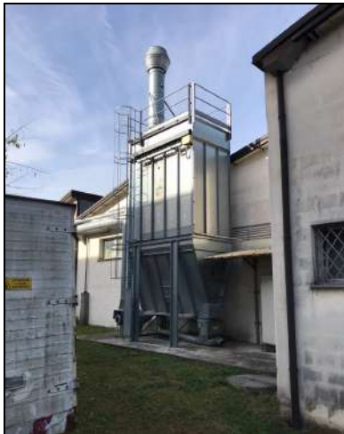
Figura 10 - Impianto di aspirazione ad ovest di Gi. Di. Meccanica S.p.A. (Sorgente S1)
