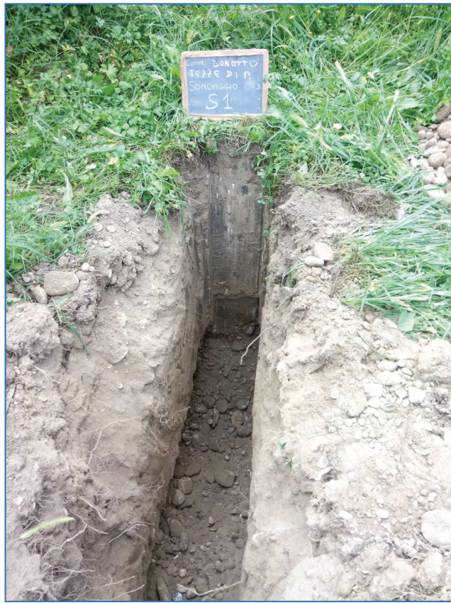
Fotografia 1 - Trincea geognostica S1
