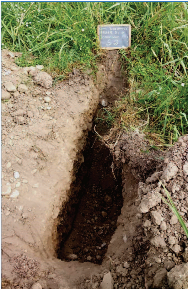
Fotografia 2 - Trincea geognostica S2
